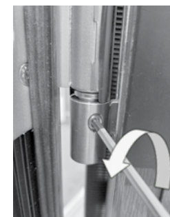
Borgschroef losdraaien.
